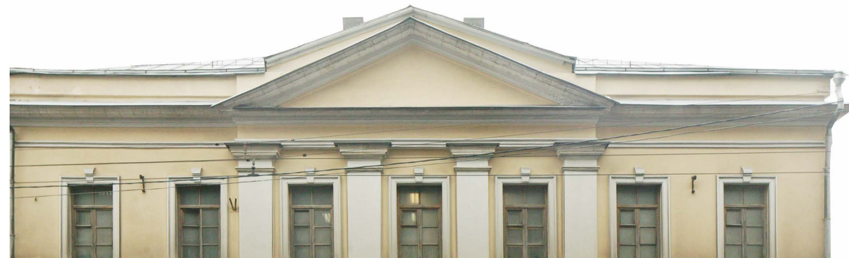
Верхняя часть здания
