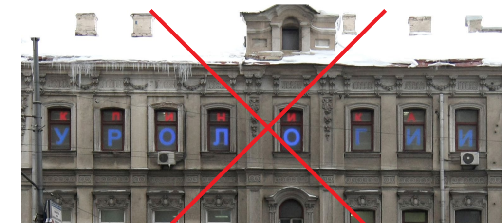
Замена оклейки в окнах на маркизы
